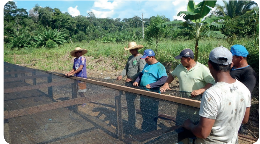
Foto 36: Etapas do terreiro sendo construído. Fonte: Acervo Idesam.
