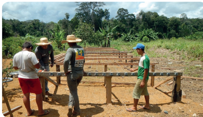
Foto 34: Etapas do terreiro sendo construído. Fonte: Acervo Idesam.
