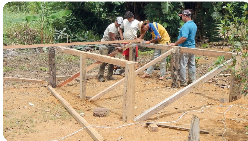
Foto 33: Etapas do terreiro sendo construído. Fonte: Acervo Idesam.
