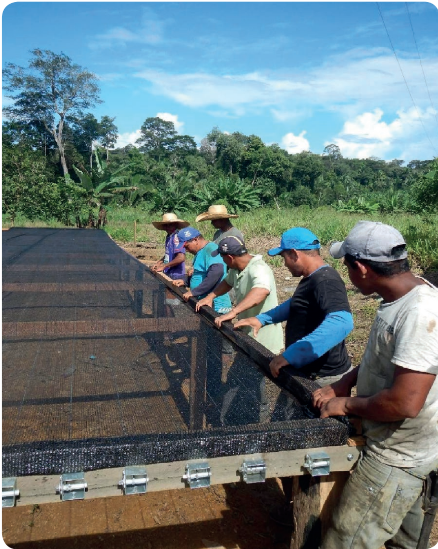
Foto 35: Etapas do terreiro sendo construído. Fonte: Acervo Idesam.
